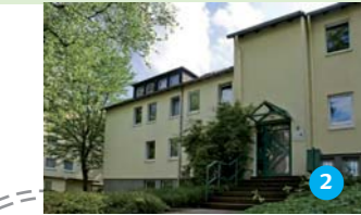
Außenwohngruppen Warthestraße, Warthestraße 2
